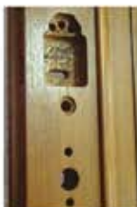
Otworowanie pod zamek elektroniczny
